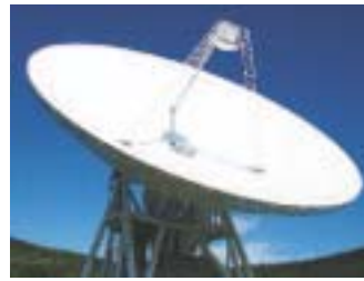
白田宇宙空間観測所の直径64mもある大パラボラアンテナ
